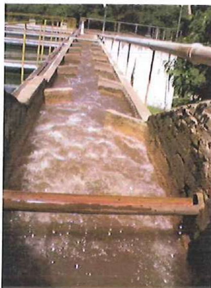
Ilustração 11: Mistura rápida
