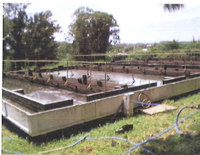
Ilustração 23: Tanque Imhoff
