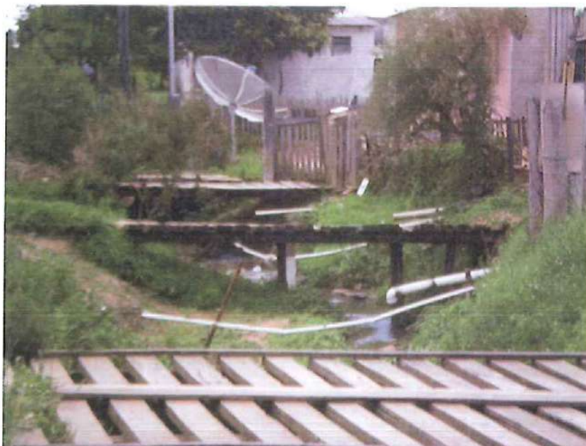
Ilustração 21: Lançamento de esgotos em córrego – Bairro Pró Morar.
