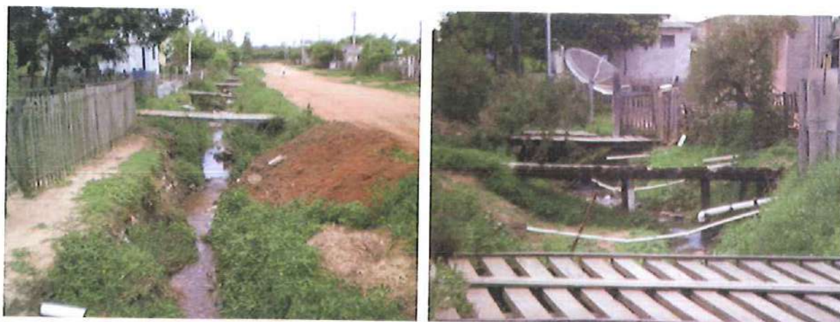
Ilustração 25 - Valas a céu aberto em ruas da cidade.
