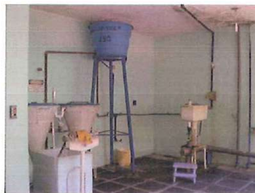
Ilustração 24 ETA - galeria de filtros e dosagem de produtos químicos.
