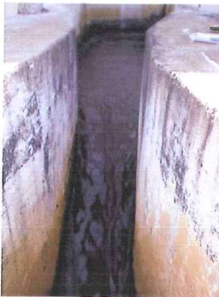
Ilustração 10: Calha Parshall
